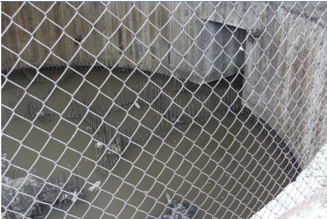
Fot. 91 Komin żelbetowy – widok na startery z fundamentu komina
