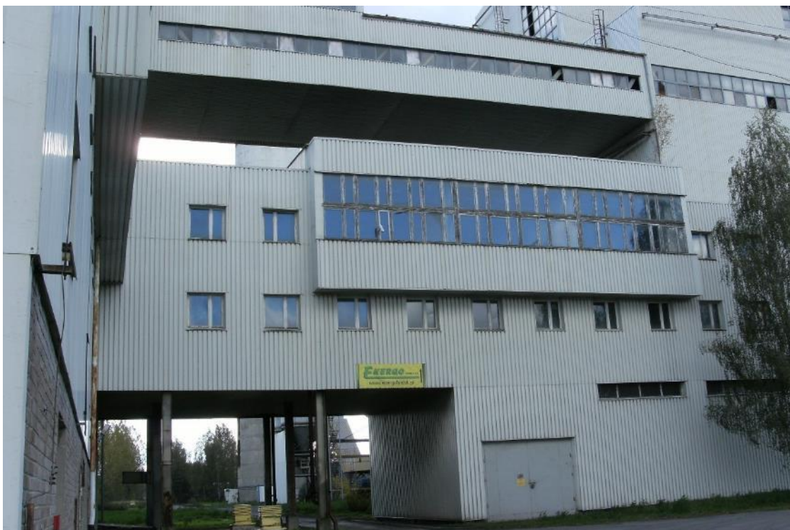
Fot. 71 Budynek BUT – budynek Usług Technicznych - widok na elewację północną
