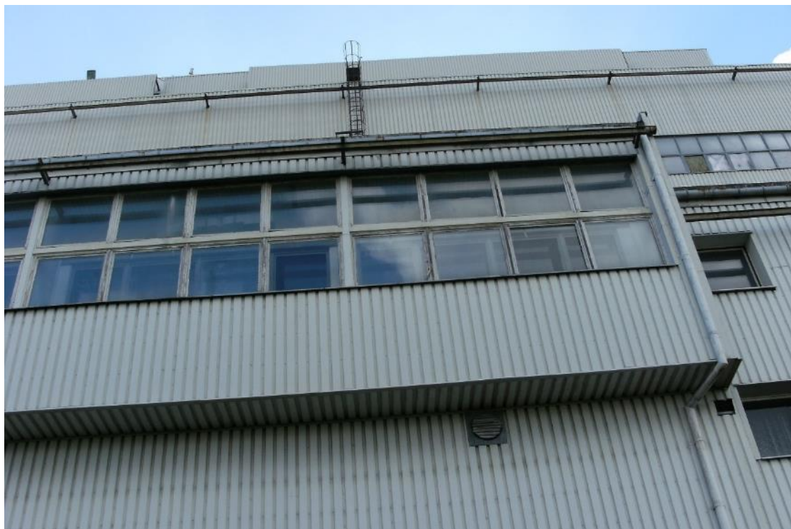
Fot. 60 Budynek BRiNK – widok na elewację północną – pomieszczenie nastawni
