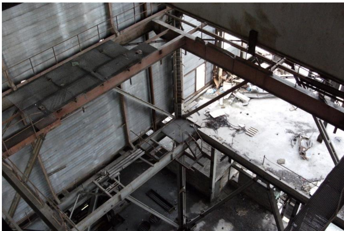
Fot. 46 Budynek BGK – widok wnętrza – widok z III piętra na kondygnacje niższe
