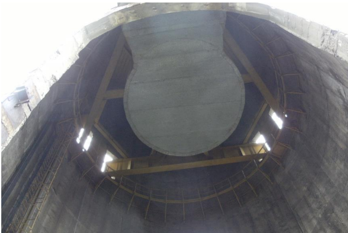
Fot. 92 Komin żelbetowy – widok na przewód dymowy komina i konstrukcję wsporczą
