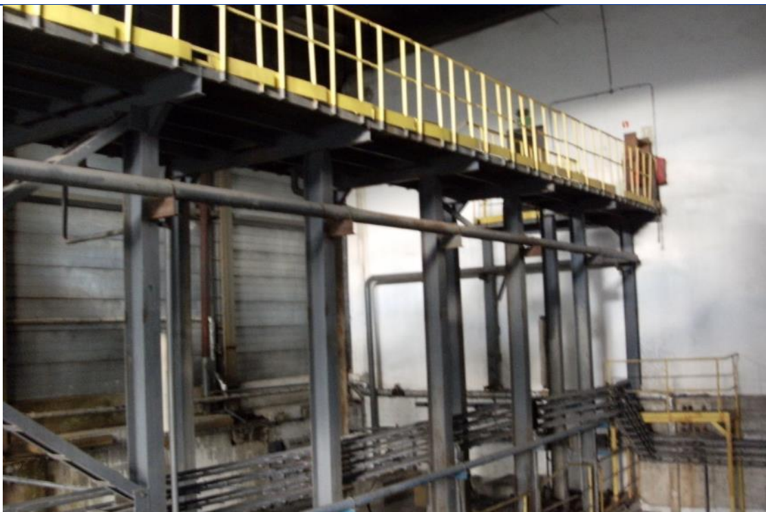
Fot. 23 Budynek PB – widok wnętrza – konstrukcja pomostu technicznego
