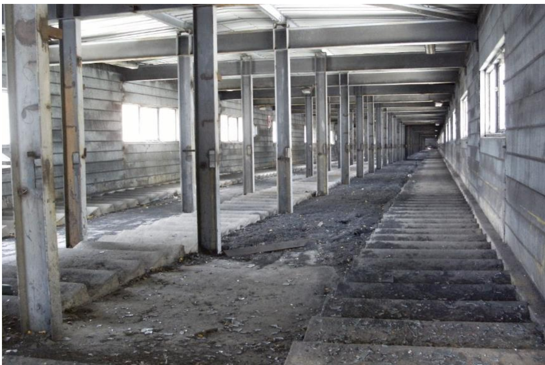
Fot. 110 Przenośnik węgla – widok wnętrza most nr 4
