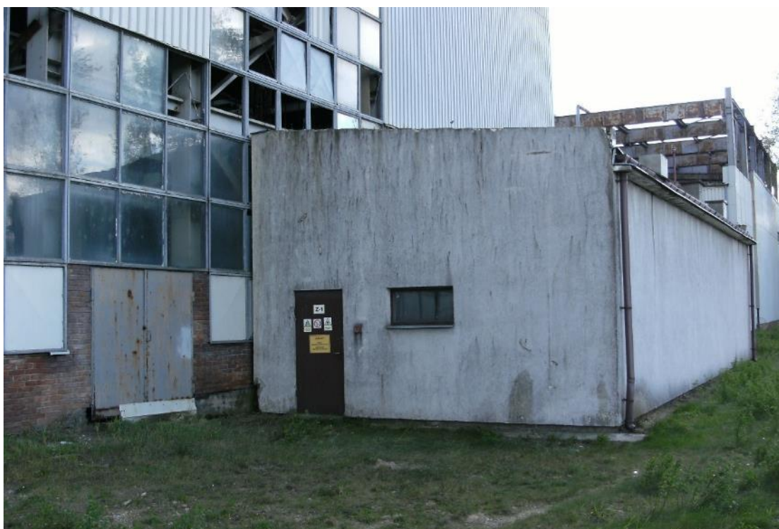
Fot. 70 Budynek BGO – widok na elewację północną i zachodnią
