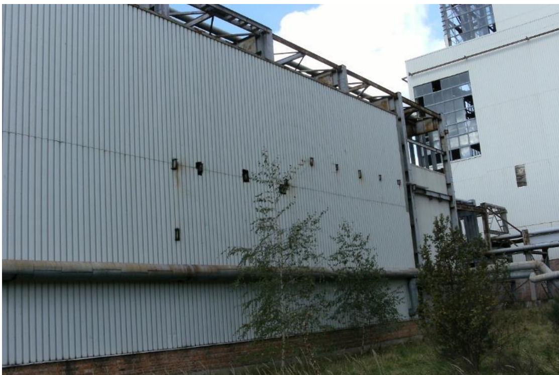
Fot. 16 Budynek PB – widok elewacji wschodniej
