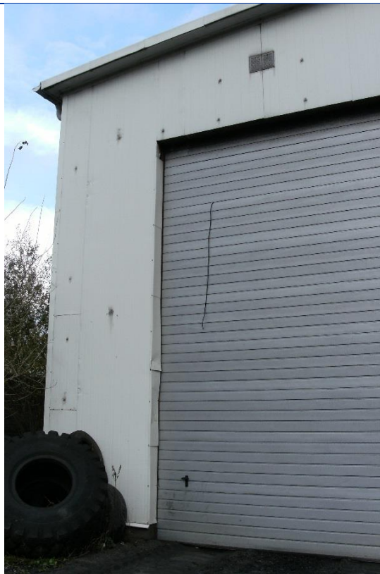
Fot. 147 Budynek magazynowy – widok na elewację zachodnią.
