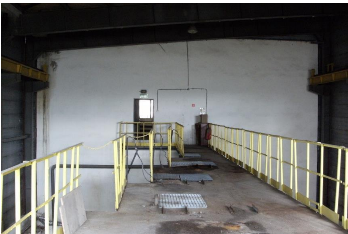
Fot. 26 Budynek PB – widok wnętrza – widok z poziomu pomostu na halę
