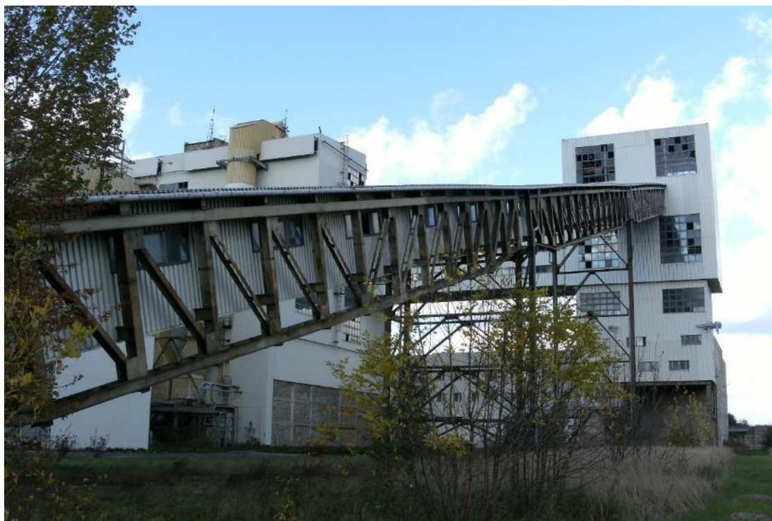
Fot. 106 Przenośnik węgla – widok na most nr 4
