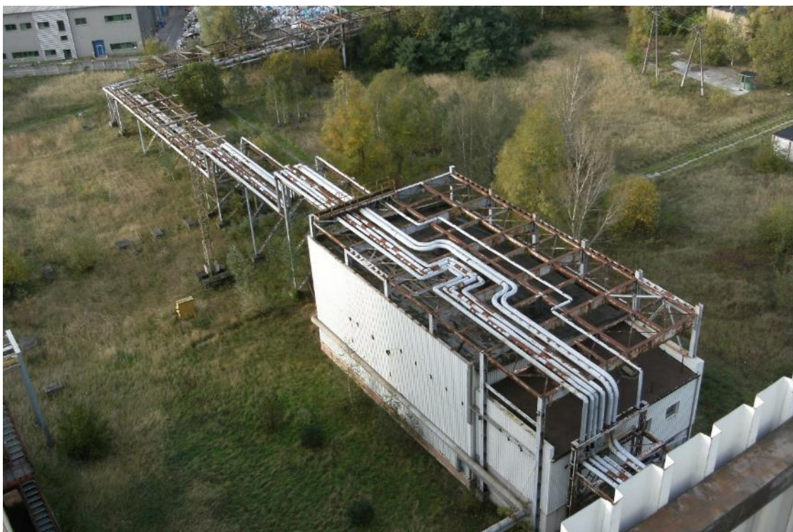
Fot. 15 Budynek PB – budynek Pompowni Bagrowej (część wyższa) z budynkiem rozdzielni i nastawni odpopielania (część niższa)
