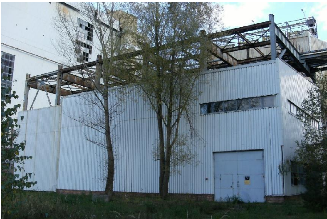
Fot. 18 Budynek PB – widok elewacji zachodniej
