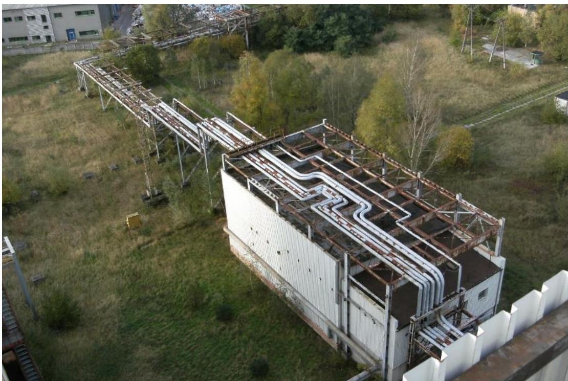
Fot. 27 Budynek BRiNO - budynek rozdzielni i nastawni odpopielania (część niższa) oraz budynek Pompowni Bagrowej (część wyższa)
