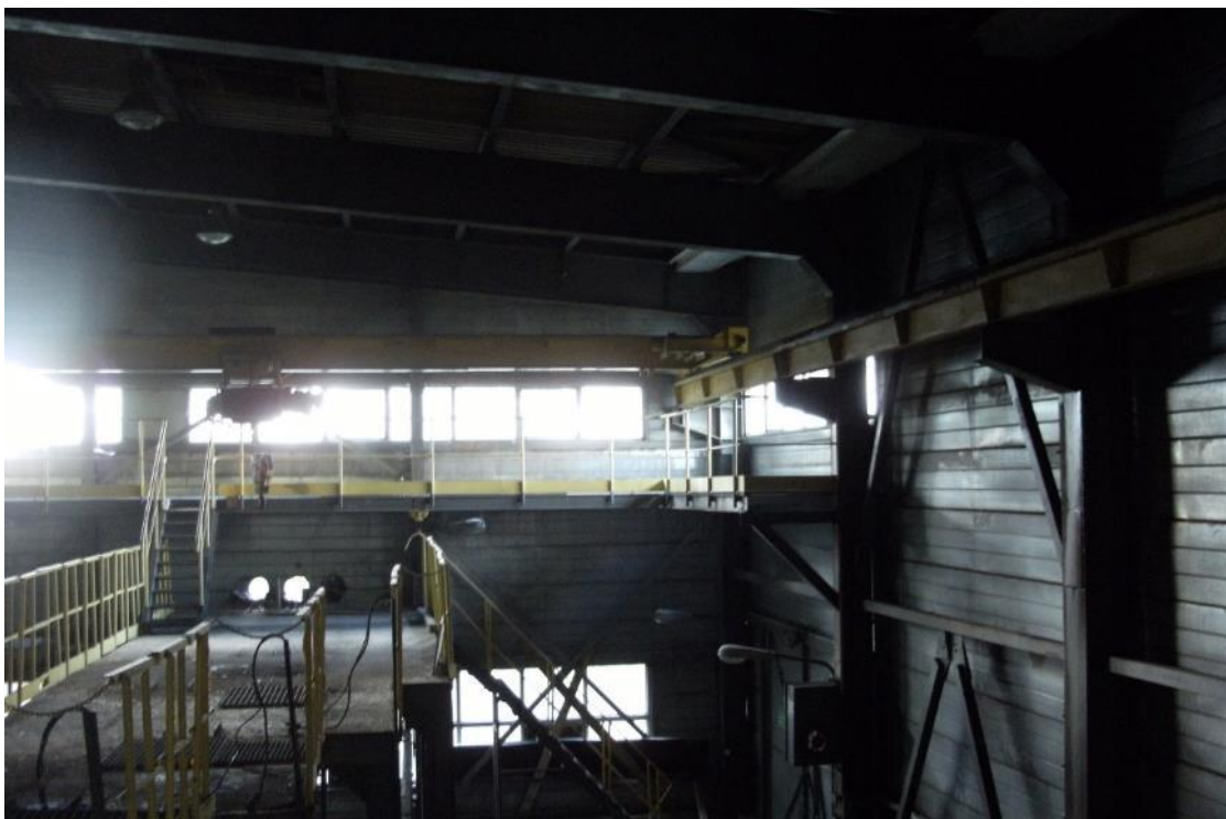
Fot. 24 Budynek PB – widok wnętrza – widok z poziomu pomostu na halę z suwnicą
