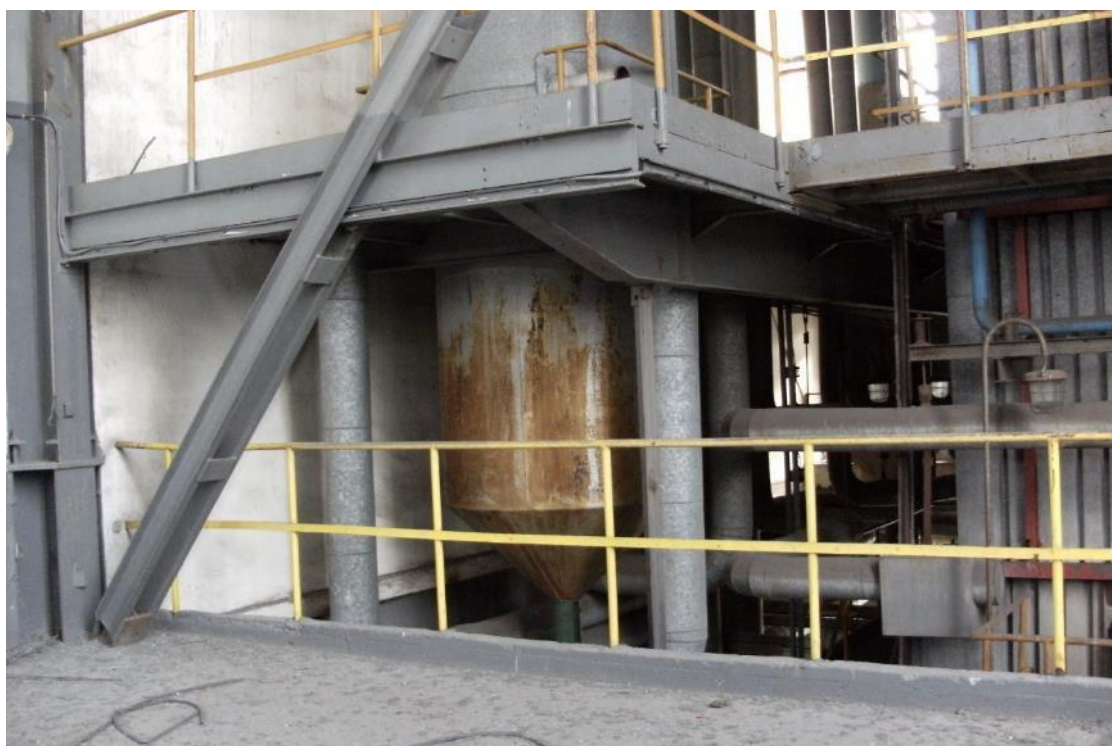
Fot. 50 Budynek BGK – widok wnętrza II piętra na pomosty kotła
