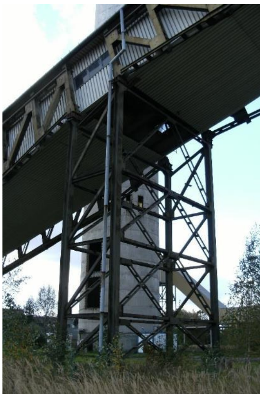
Fot. 107 Przenośnik węgla – widok na most nr 4 podpora pośrednia
