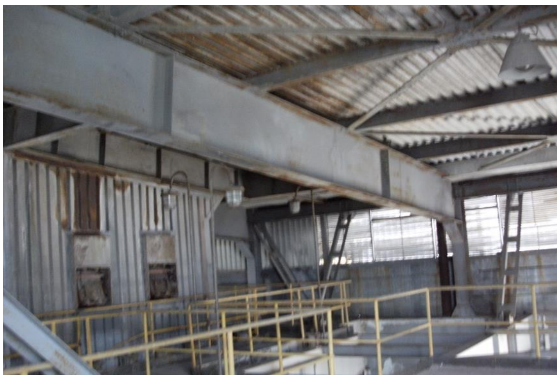
Fot. 44 Budynek BGK – widok wnętrza III piętra – konstrukcja dachu
