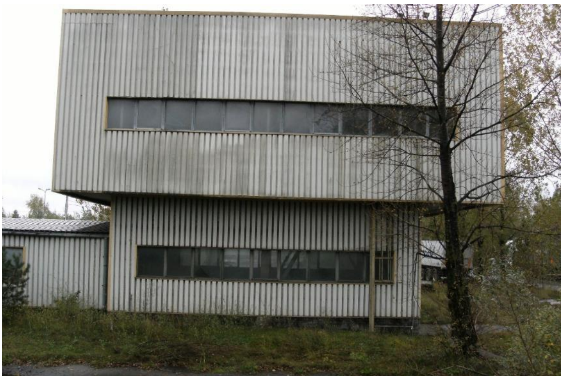
Fot. 123 Budynek przesypu nr 2 - widok na elewację północną
