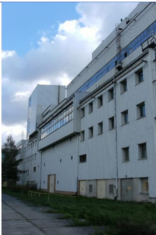
Fot. 35 Budynek BGK – widok na elewację północną
