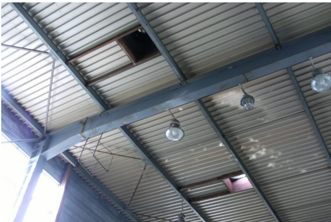
Fot. 102 Wieża nawęglania – widok wnętrza na konstrukcję dachu
