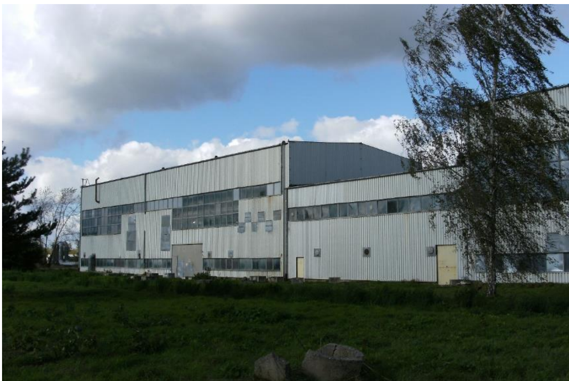
Fot. 4 Budynek PWS - elewacja północna - segment lewy pompownia i środkowy niższy
