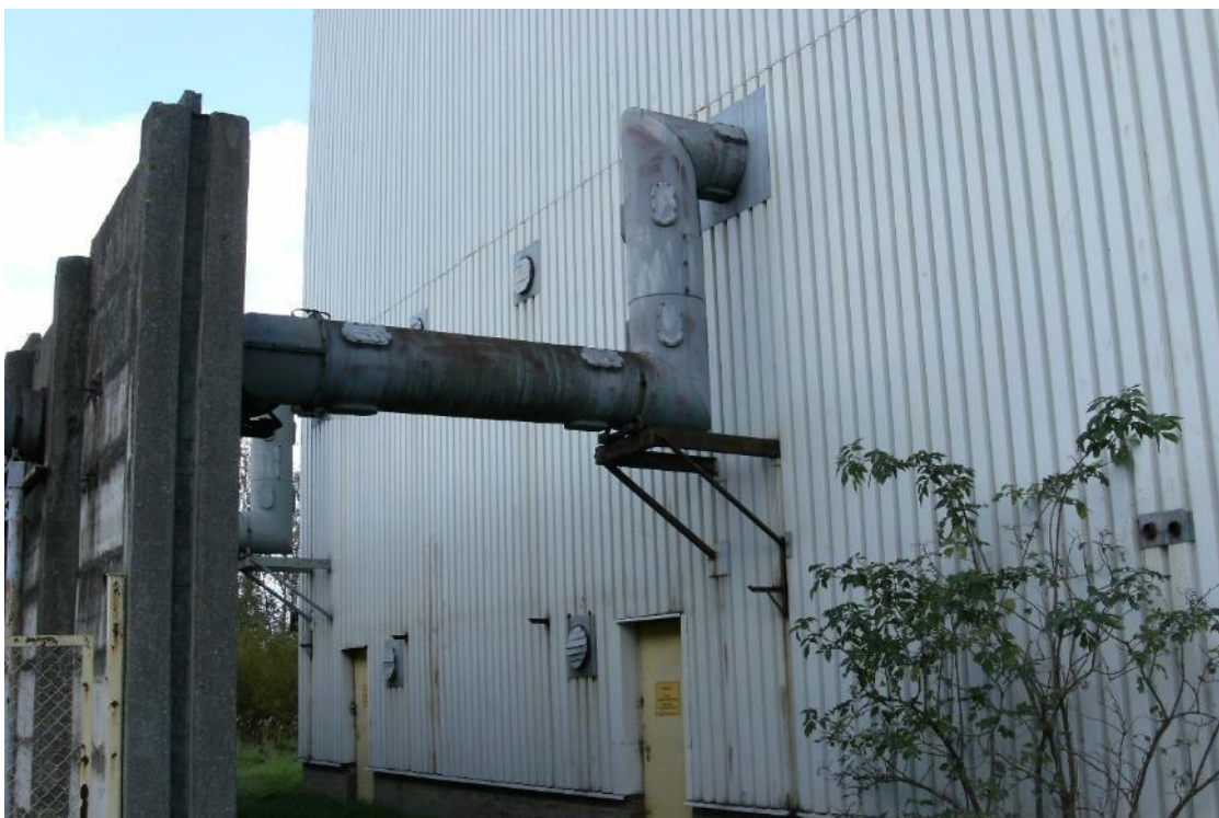
Fot. 79 Budynek DCE – widok na elewację północną budynku
