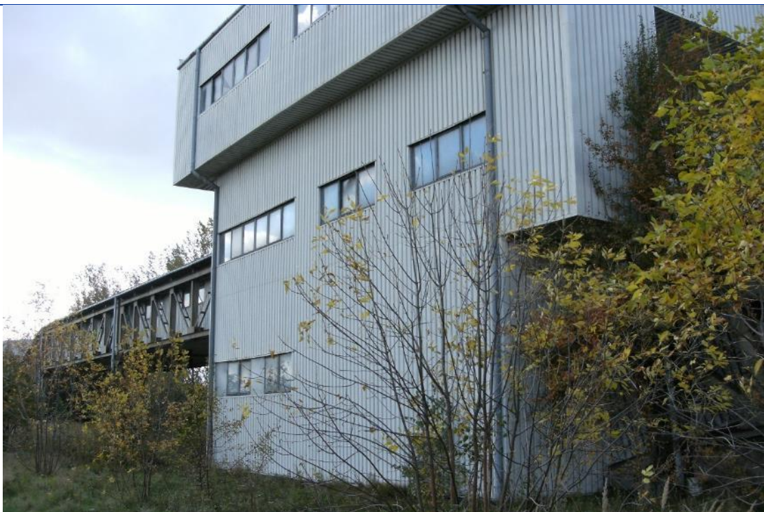
Fot. 116 Budynek przesypu nr 4 - widok na elewację wschodnią
