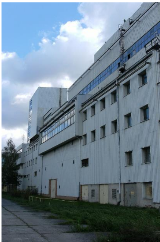
Fot. 59 Budynek BRiNK – budynek Rozdzielni i Nastawni - widok na elewację północną
