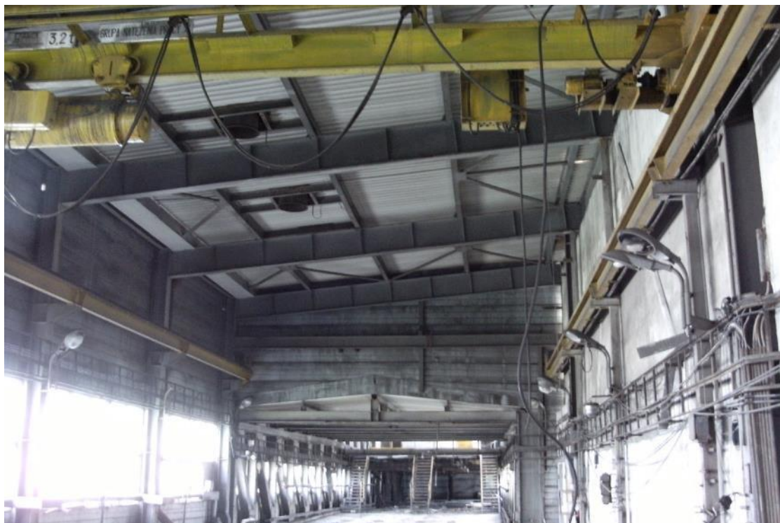
Fot. 48 Budynek BGK – widok wnętrza II piętra na łącznik transportowy
