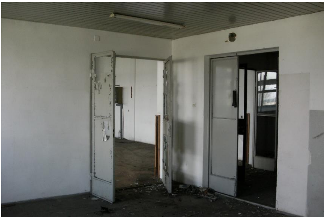
Fot. 65 Budynek BRiNK – widok wnętrza – pomieszczenia budynku
