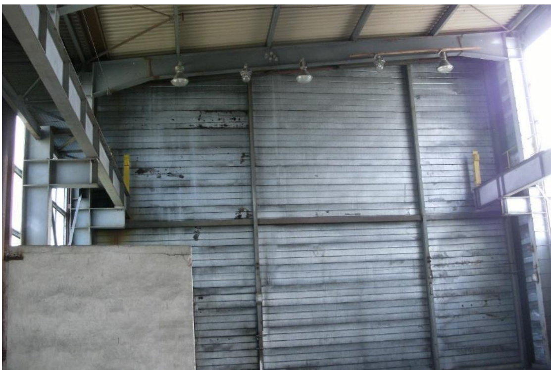
Fot. 103 Wieża nawęglania – widok wnętrza na ścianę budynku
