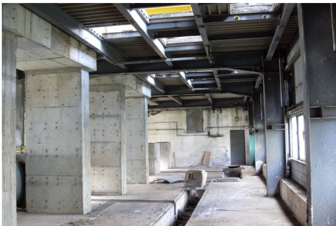
Fot. 10 Budynek PWS - widok wnętrza – segment lewy - pompownia kondygnacja dolna
