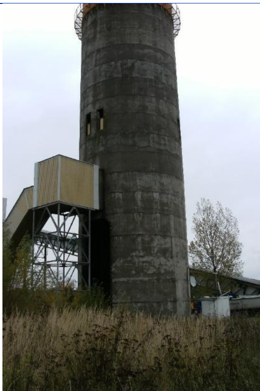
Fot. 89 Komin żelbetowy – widok podstawy komina
