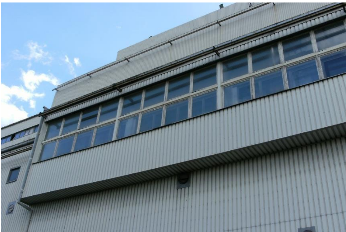
Fot. 61 Budynek BRiNK – widok na elewację północną – pomieszczenie nastawni
