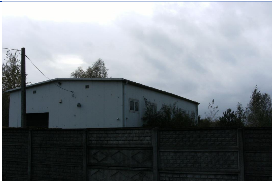
Fot. 149 Budynek magazynowy – widok na elewację północno- wschodnią.
