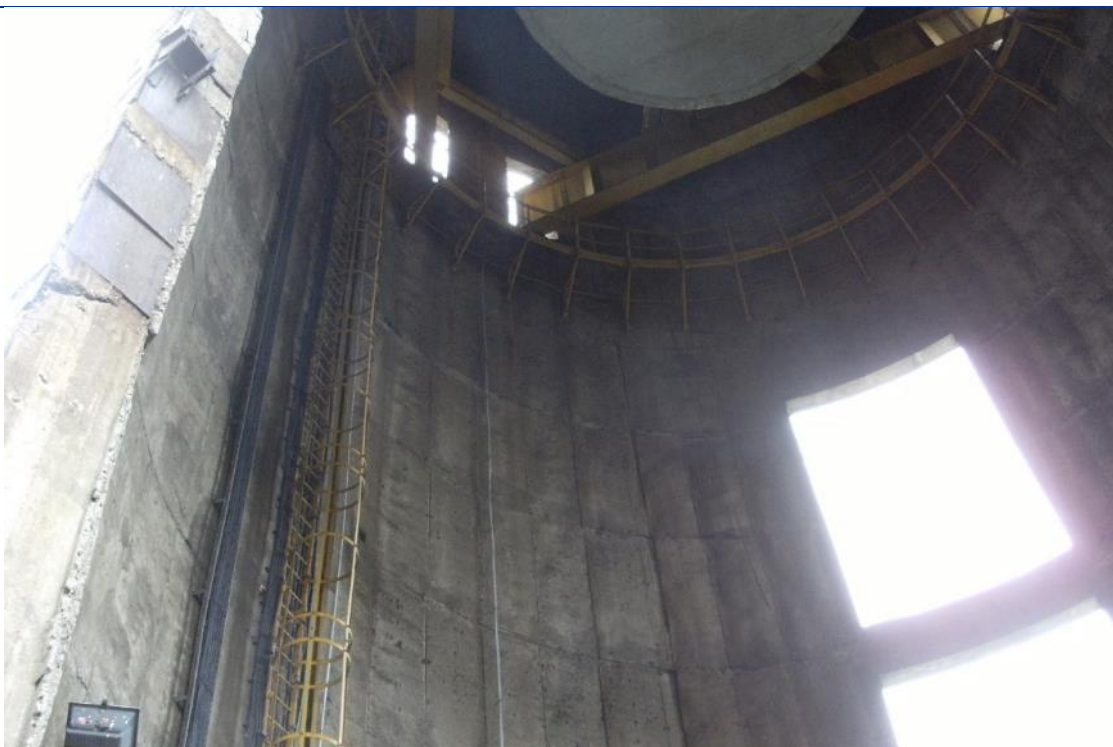
Fot. 93 Komin żelbetowy – widok na konstrukcje wsporczą oraz otwory w trzonie komina
