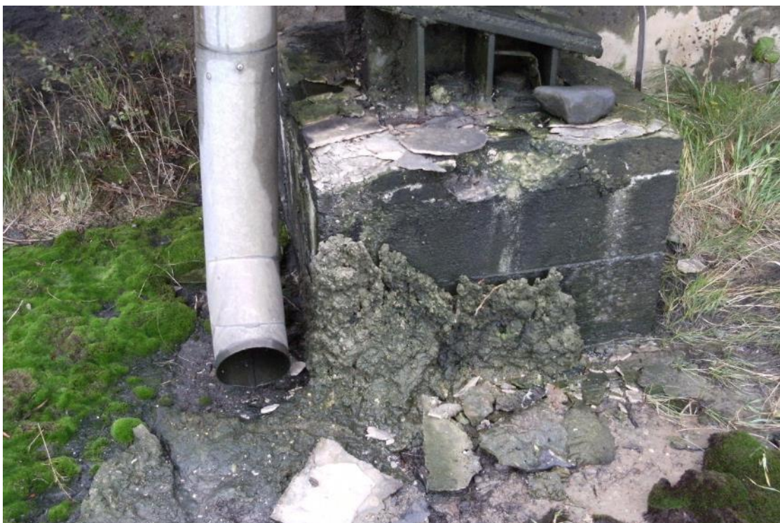
Fot. 108 Przenośnik węgla – widok na podporę skrajną mostu nr 4
