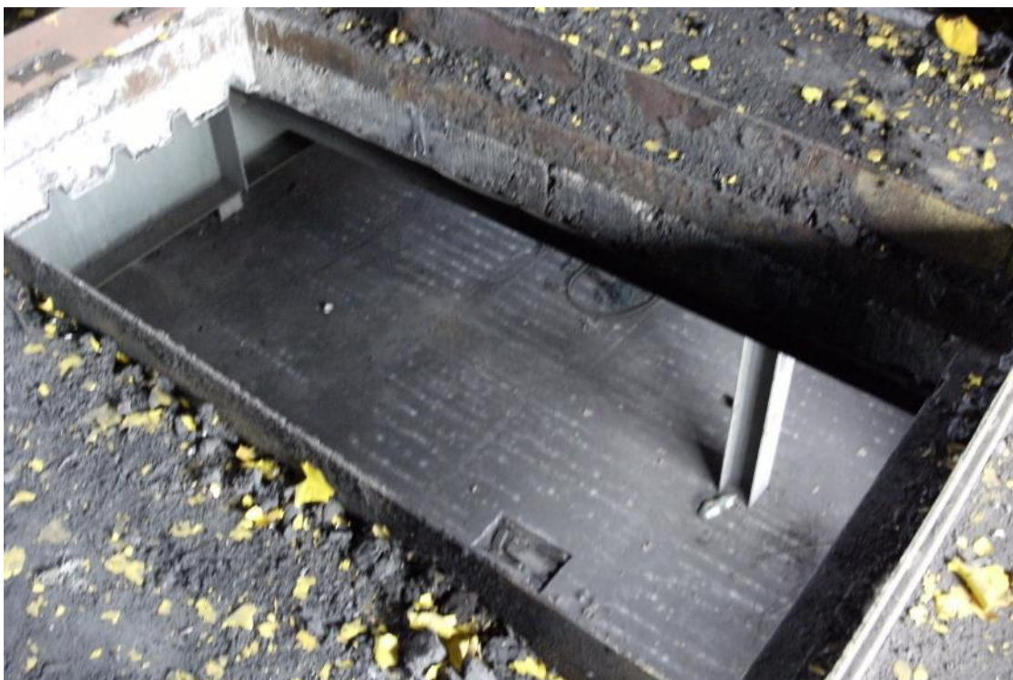
Fot. 119 Budynek przesypu nr 4 - widok na otwór technologiczny w stropie
