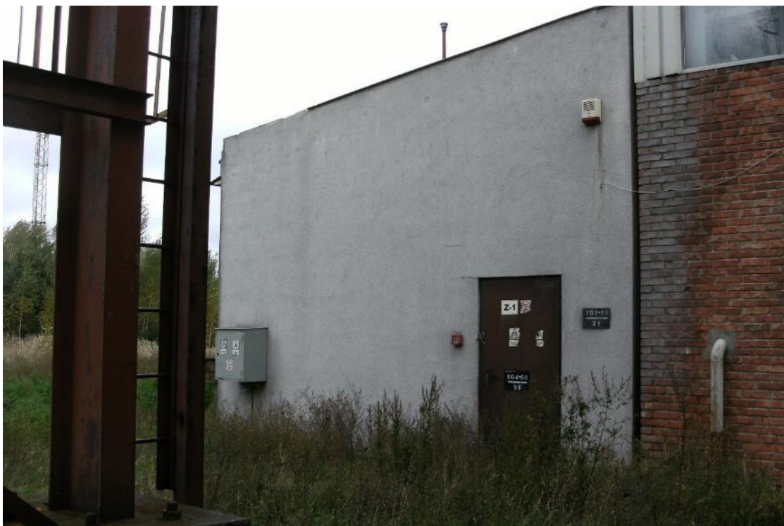
Fot. 69 Budynek BGO – budynek Gospodarki Olejowej - widok na elewację południową
