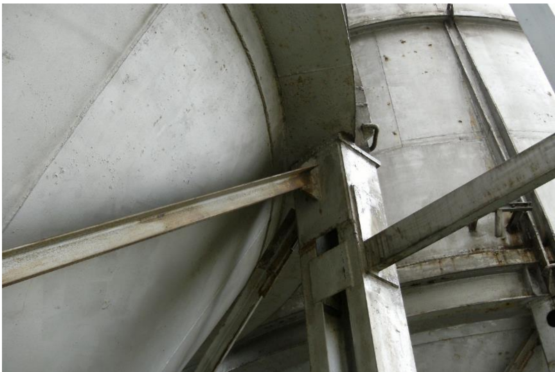
Fot. 140 Silosy – widok na węzeł podpory silosu
