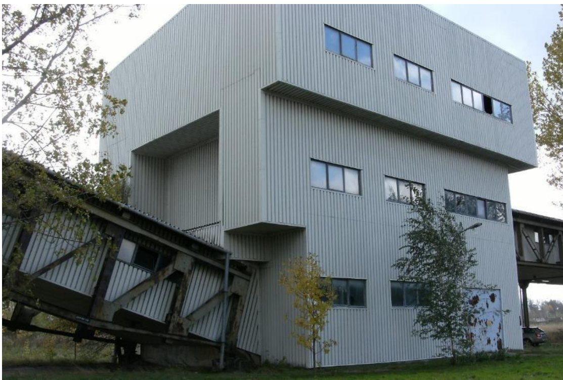
Fot. 115 Budynek przesypu nr 4 - widok na elewację północno-zachodnią
