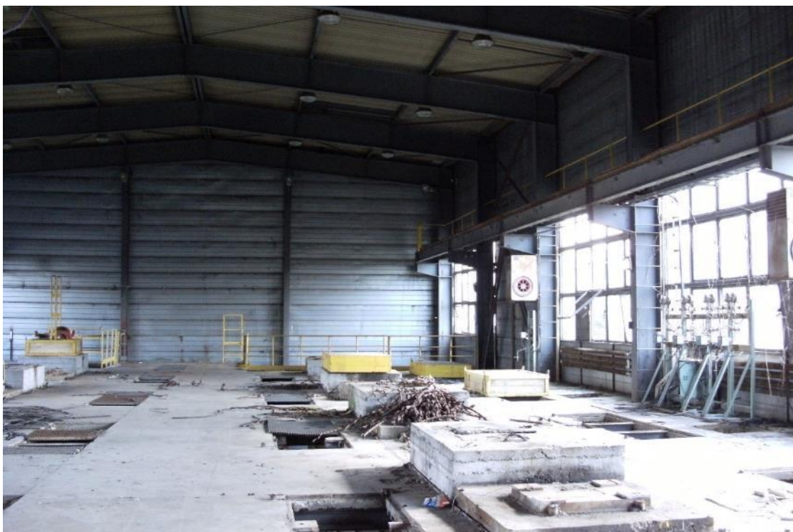
Fot. 7 Budynek PWS - widok wnętrza – segment lewy - pompownia kondygnacja górna
