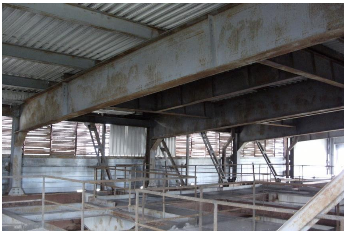
Fot. 43 Budynek BGK – widok wnętrza III piętra – konstrukcja dachu
