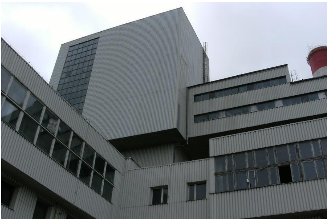
Fot. 96 Wieża nawęglania – widok na elewację północno-zachodnią
