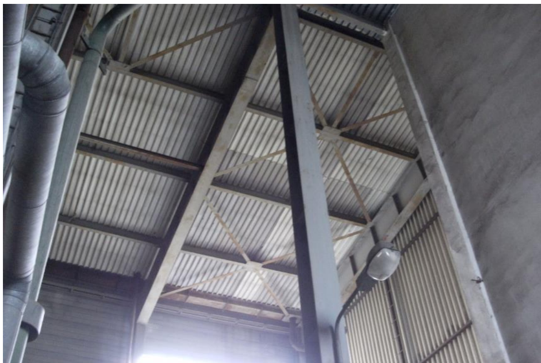
Fot. 54 Budynek BGK – widok wnętrza I piętra na dach
