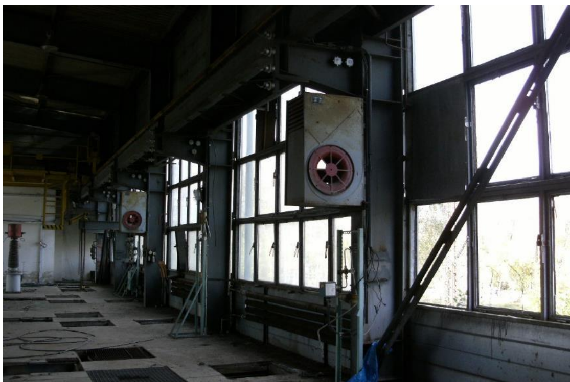
Fot. 9 Budynek PWS - widok wnętrza – segment lewy - pompownia kondygnacja górna
