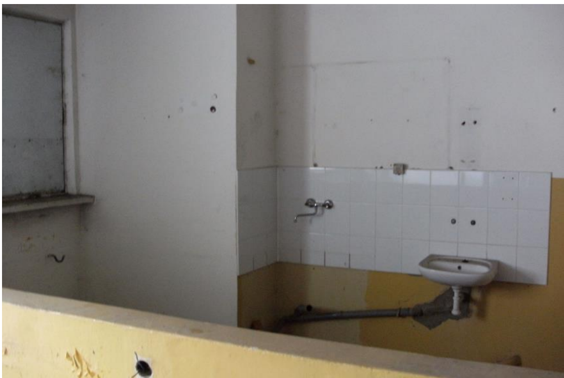
Fot. 86 Budynek DCE – widok wnętrza pomieszczenia sanitarnego
