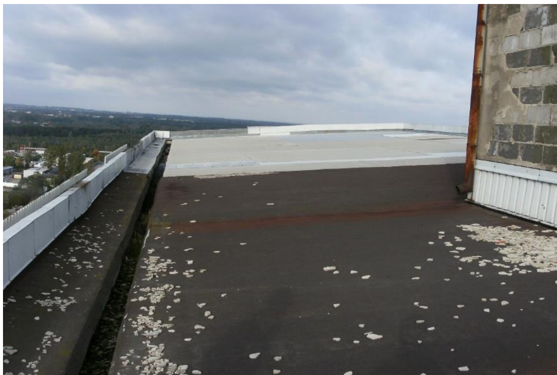
Fot. 40 Budynek BGK – przykrycie części najwyższej budynku
