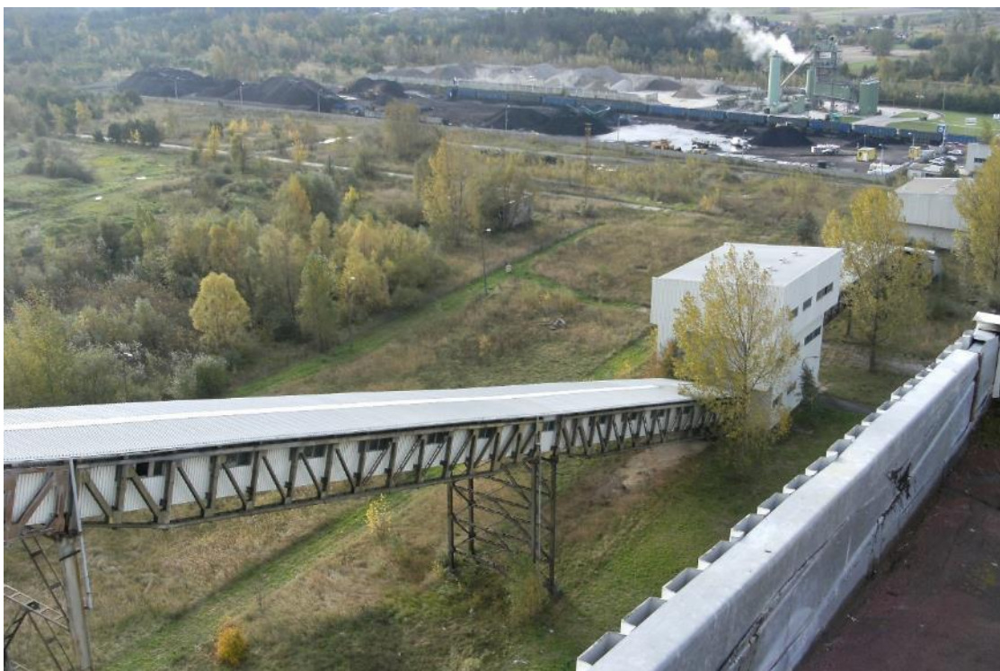
Fot. 114 Budynek przesypu - panorama na budynek przesypu nr 4 , 3 i 2 obok placu składowania węgla
