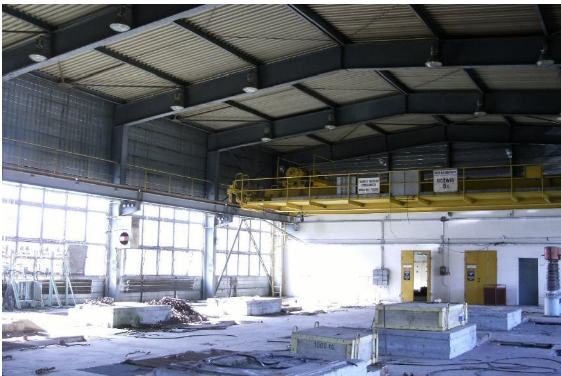
Fot. 8 Budynek PWS - widok wnętrza – segment lewy - pompownia kondygnacja górna
