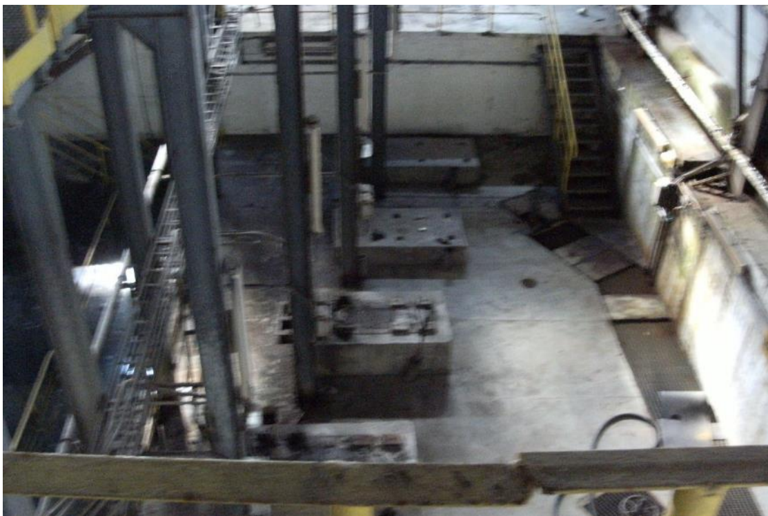
Fot. 20 Budynek PB – widok wnętrza – strop części naziemnej
