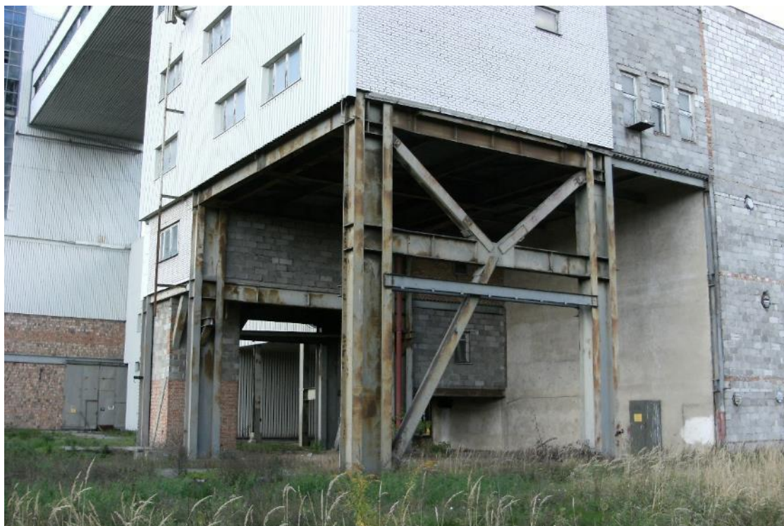
Fot. 82 Budynek DCE – widok na elewację południowo wschodnią budynku
