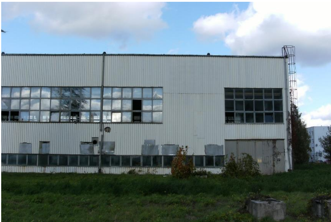
Fot. 2 Budynek PWS - elewacja północna, segment prawy wymiennikownia
