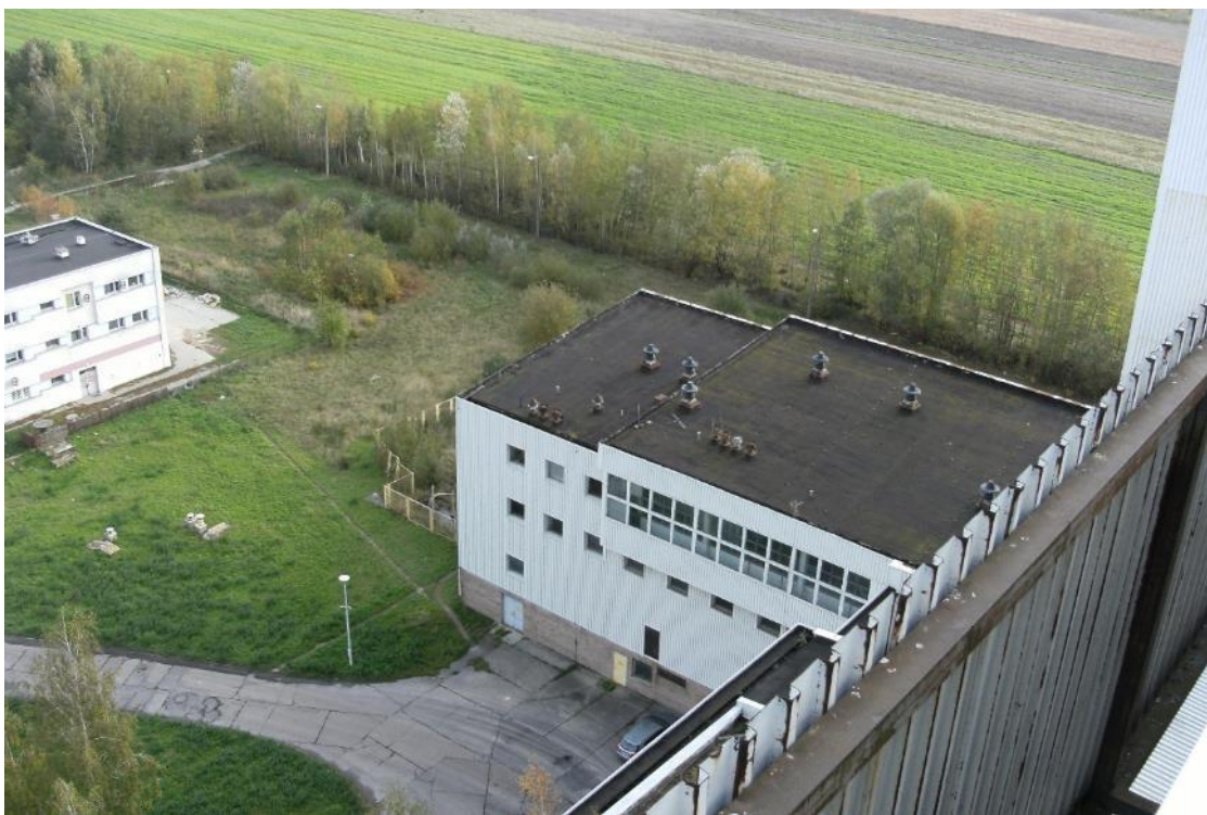
Fot. 77 Budynek DCE – budynek Dyspozytorni Ciepłownictwa - widok na elewację zachodnią i dach budynku
