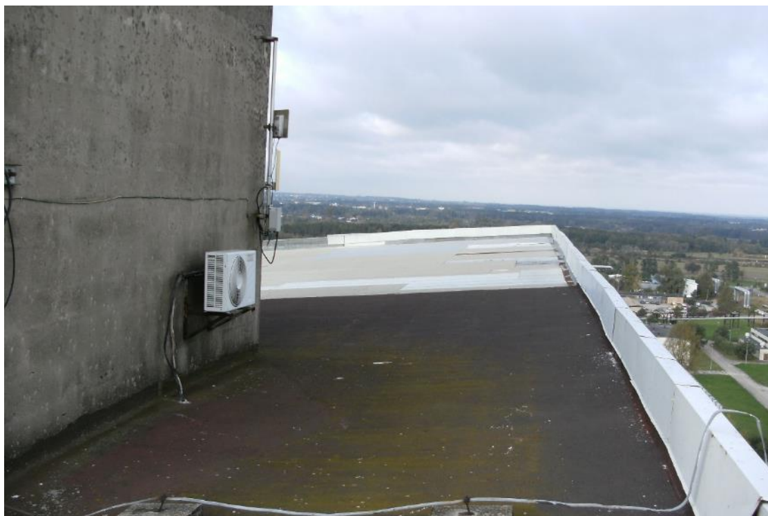
Fot. 41 Budynek BGK – przykrycie części najwyższej budynku
