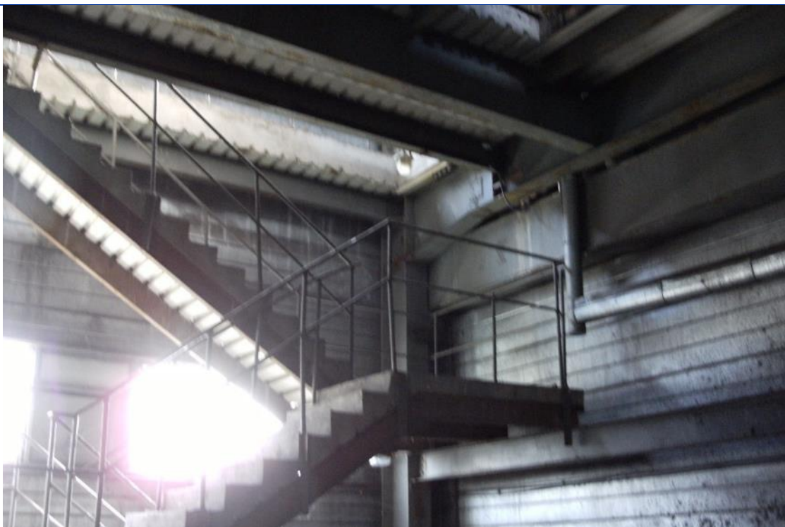
Fot. 118 Budynek przesypu nr 4 - widok wnętrza na schody
