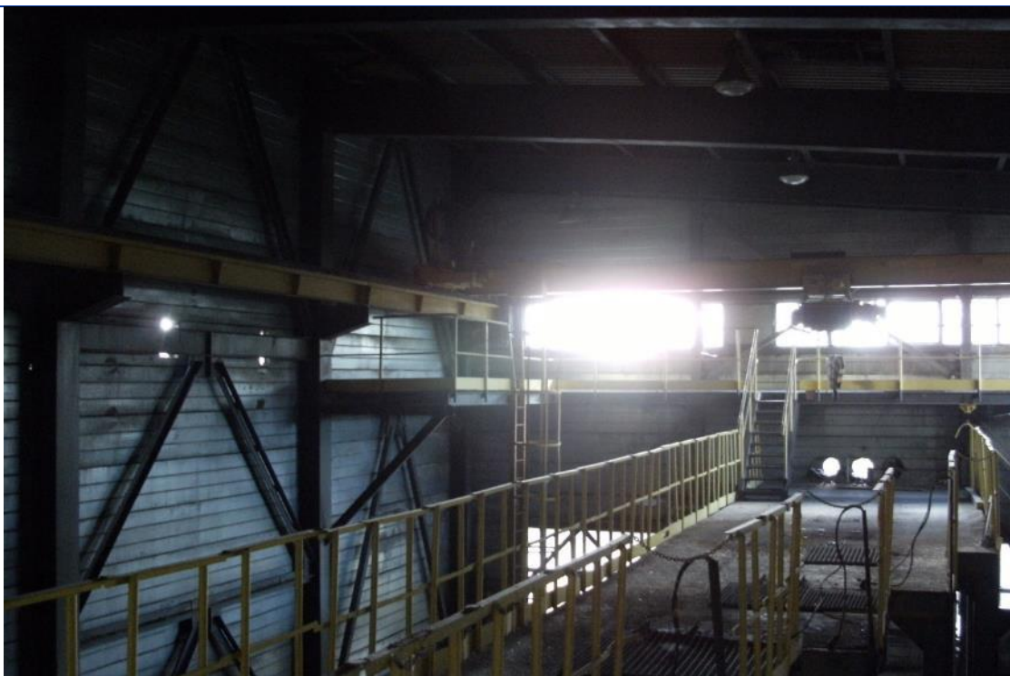
Fot. 25 Budynek PB – widok wnętrza – widok z poziomu pomostu na halę z suwnicą
