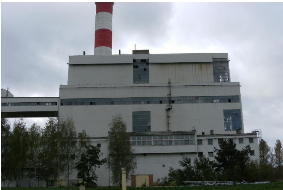
Fot. 34 Budynek BGK – budynek główny kotłowni - widok na elewację północną
