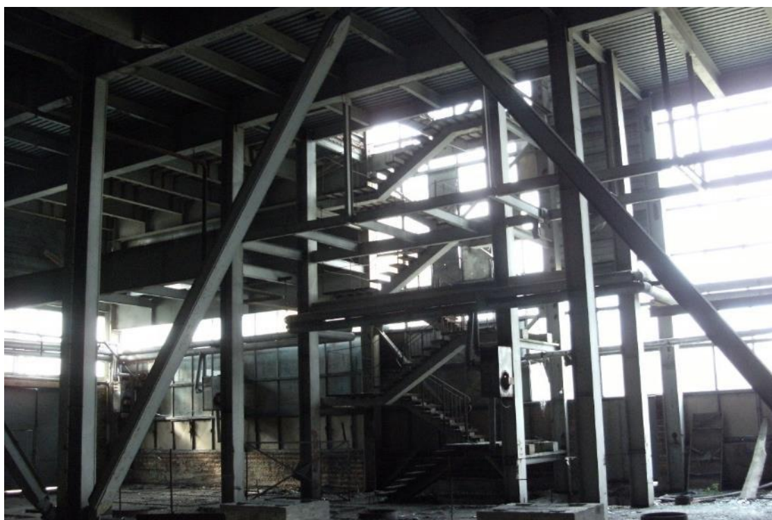
Fot. 57 Budynek BGK – widok wnętrza parteru na schody na kondygnacje wyższe
