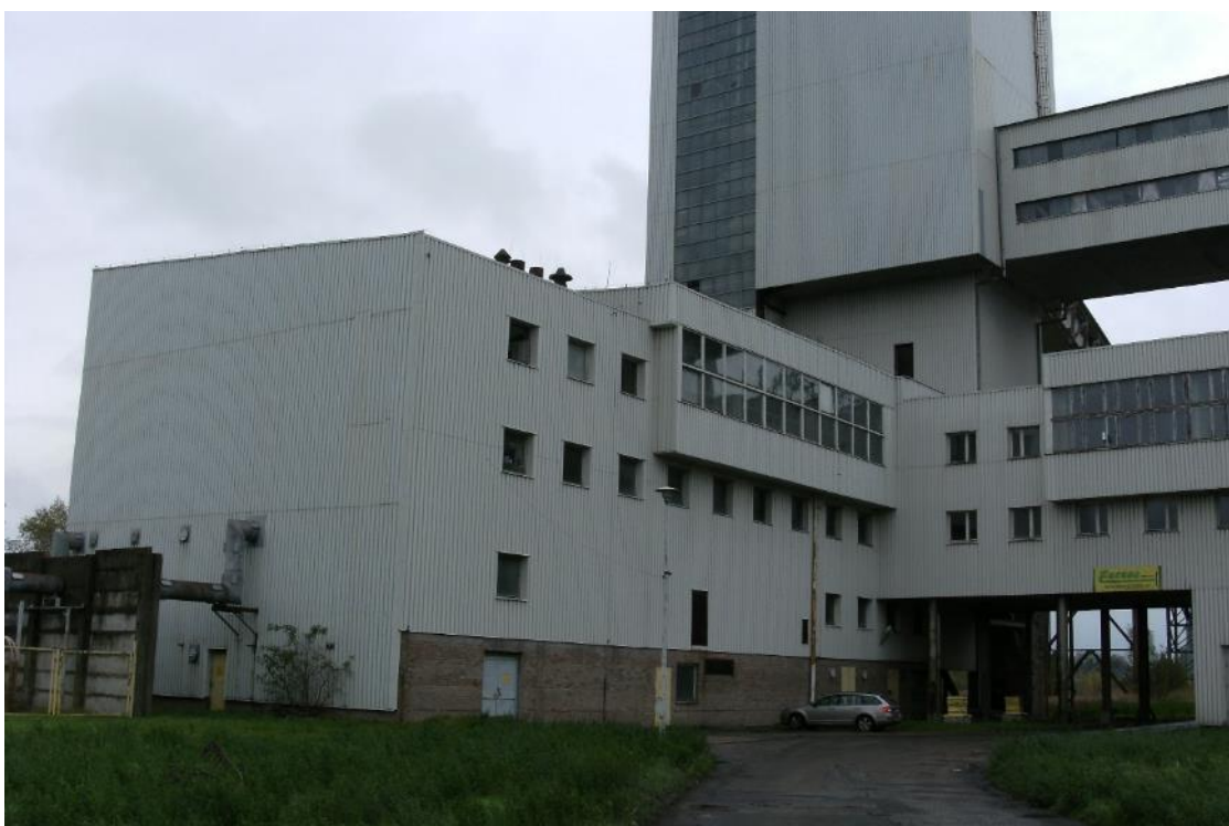
Fot. 78 Budynek DCE – widok na elewację zachodnią i północną budynku
