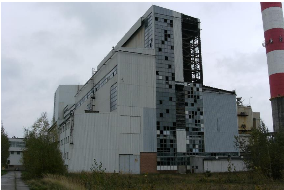
Fot. 36 Budynek BGK – widok na elewację zachodnią
