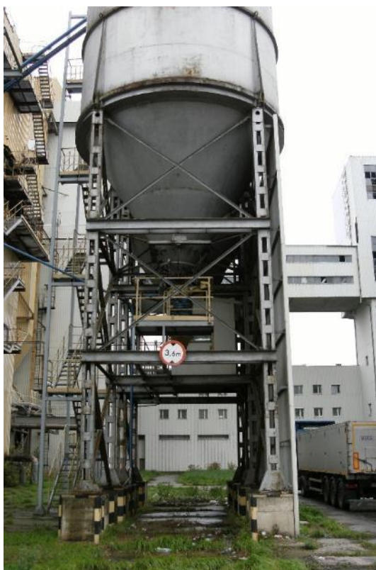
Fot. 136 Silosy – widok na stronę południową
