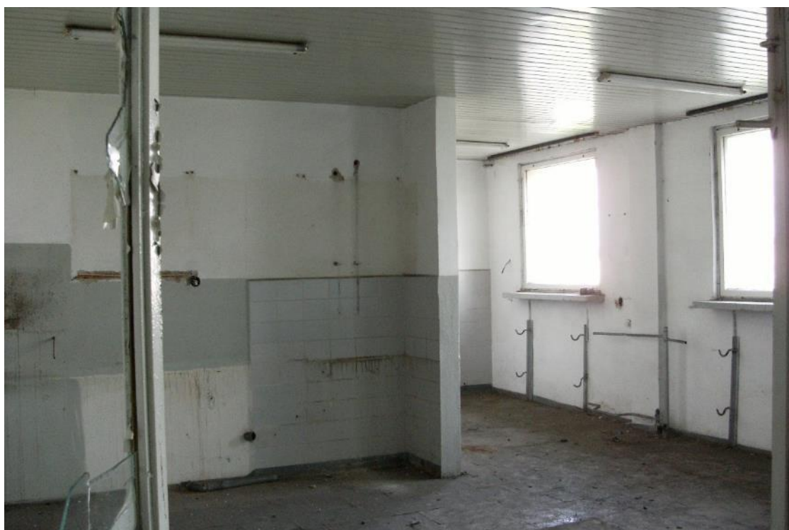
Fot. 64 Budynek BRiNK – widok wnętrza – pomieszczenia socjalne
