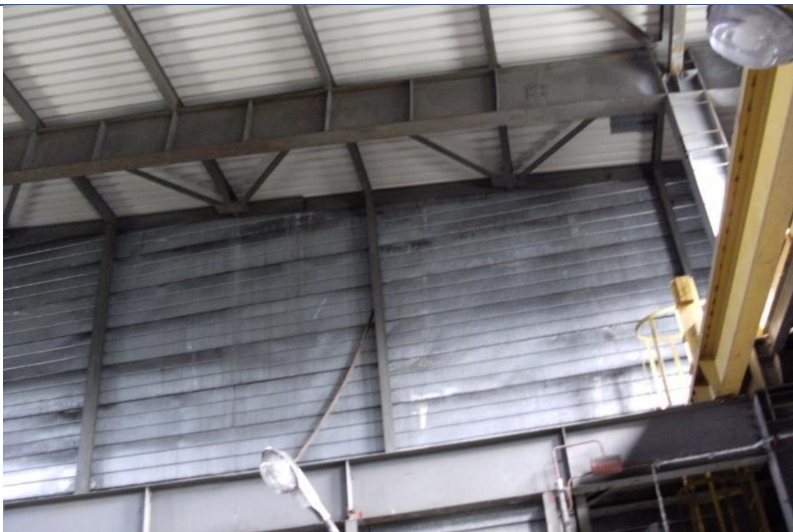
Fot. 120 Budynek przesypu nr 4 - widok wnętrza na konstrukcję dachu
