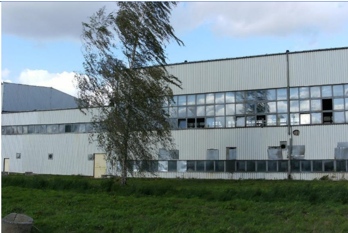
Fot. 3 Budynek PWS - elewacja północna - segment prawy wymiennikownia i środkowy niższy
