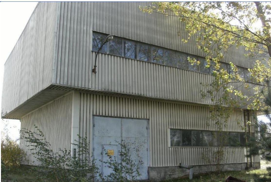
Fot. 122 Budynek przesypu nr 3 - widok na elewację północno-zachodnią
