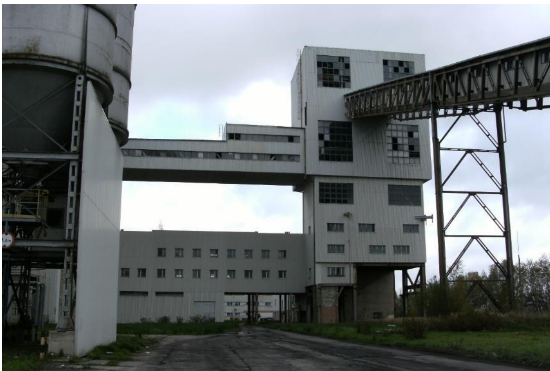
Fot. 94 Wieża nawęglania - widok na elewację południową
