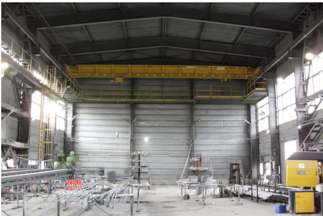
Fot. 6 Budynek PWS - widok wnętrza – segment prawy wymiennikownia
