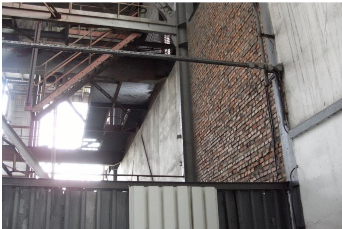
Fot. 49 Budynek BGK – widok wnętrza II piętra na ściany
