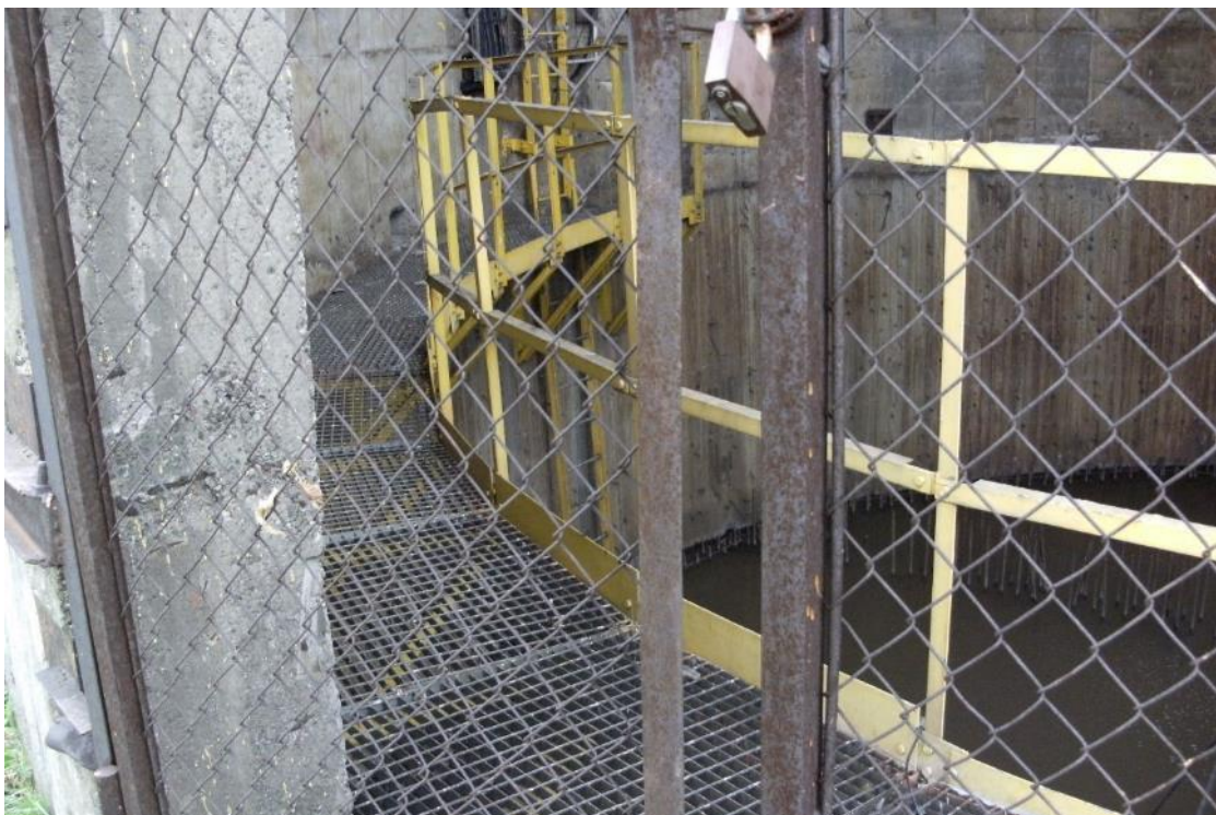
Fot. 90 Komin żelbetowy – widok na pomost wewnętrzny komina
