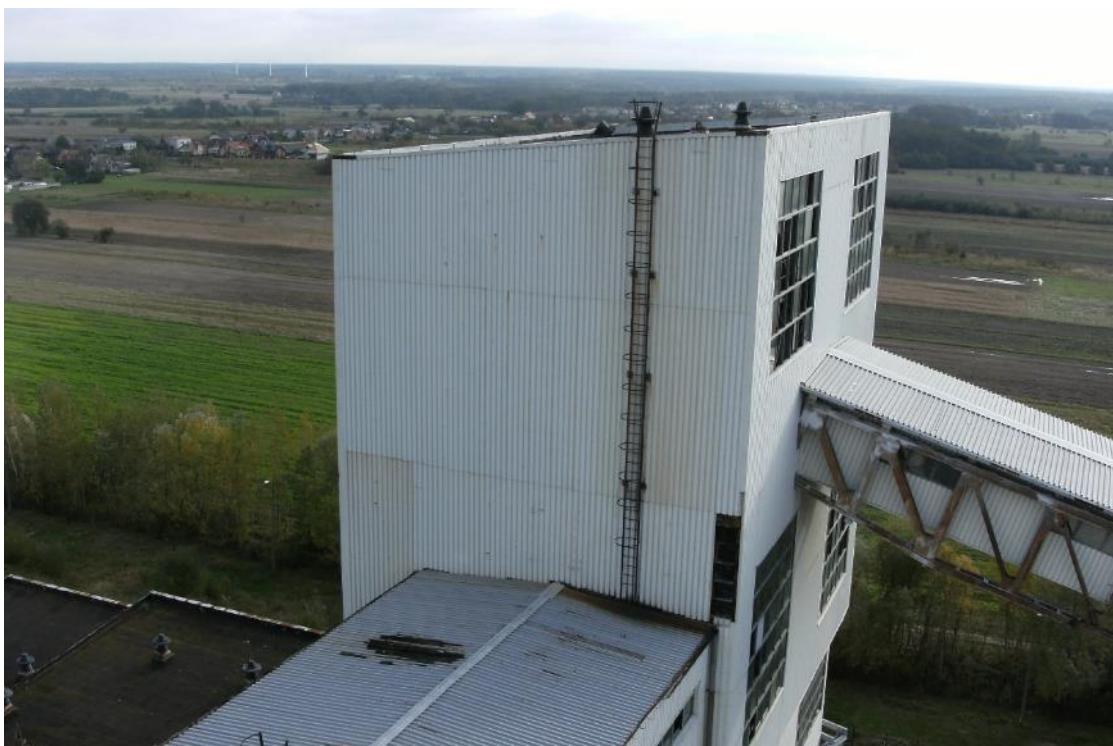
Fot. 95 Wieża nawęglania – widok na elewację południowo-zachodnią
