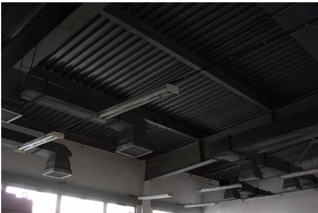
Fot. 67 Budynek BRiNK – widok wnętrza – konstrukcja dachu budynku
