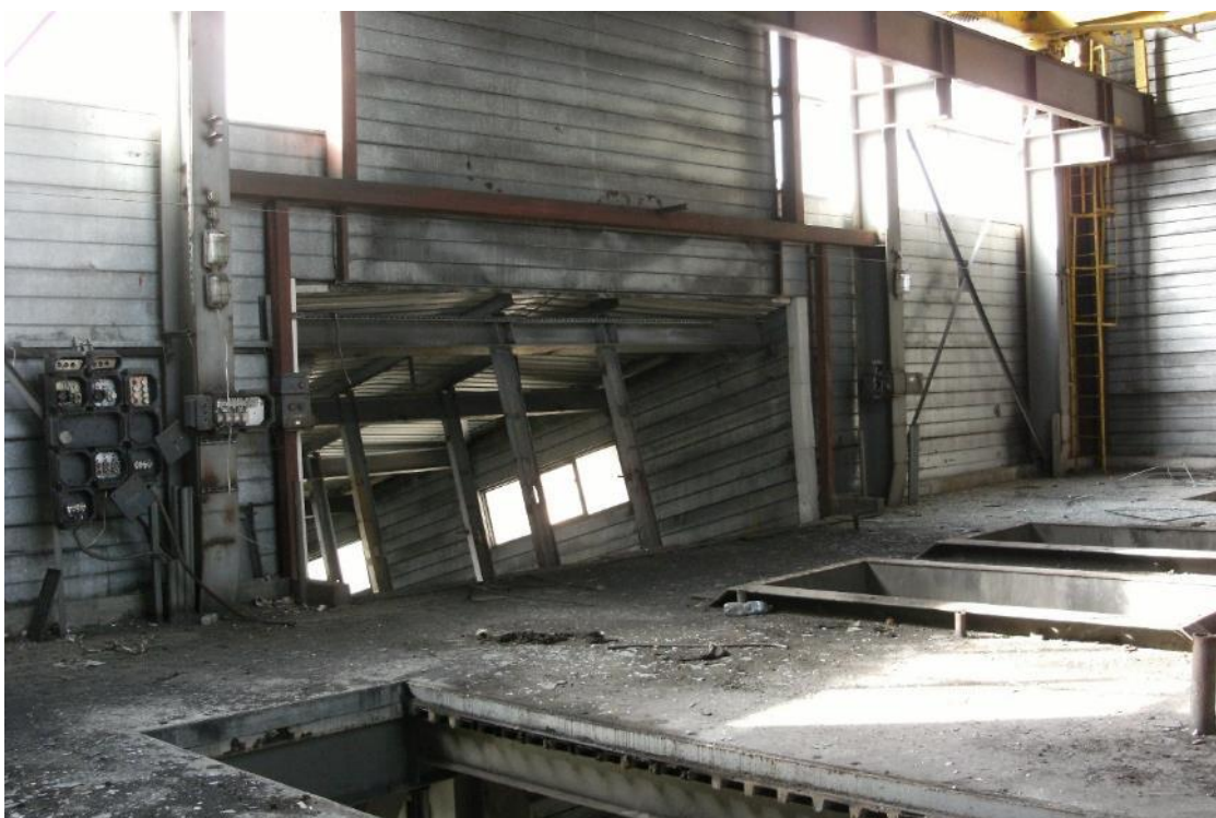
Fot. 100 Wieża nawęglania – widok wnętrza na pochyły most transportowy
