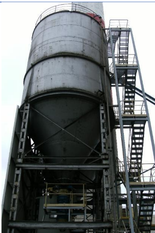
Fot. 135 Silosy – widok na stronę północną
