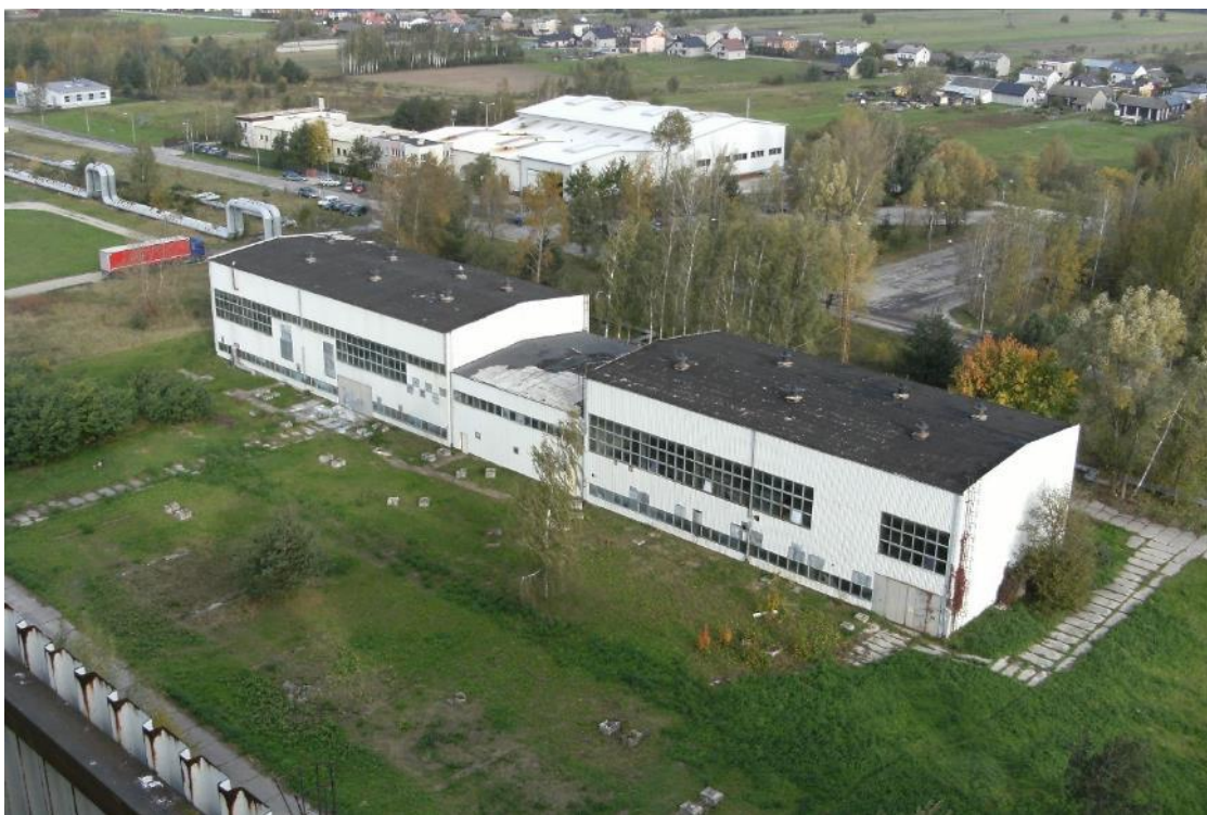
Fot. 1 Budynek PWS – budynek pompowni wody ściekowej - elewacja południowa, segmenty: segment lewy pompownia bliżej na zdjęciu, segment środkowy niższy, segment prawy wymiennikownia na końcu
