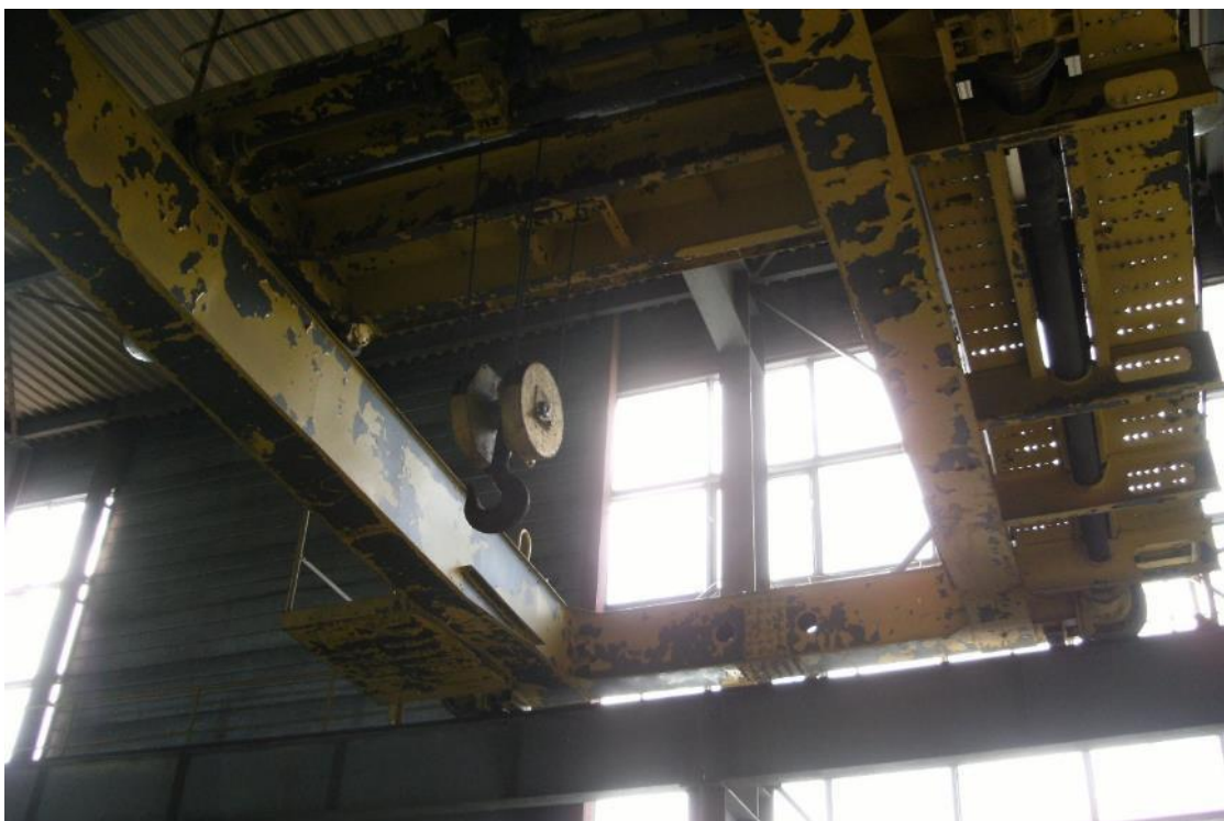
Fot. 101 Wieża nawęglania – widok wnętrza na suwnicę natorową
