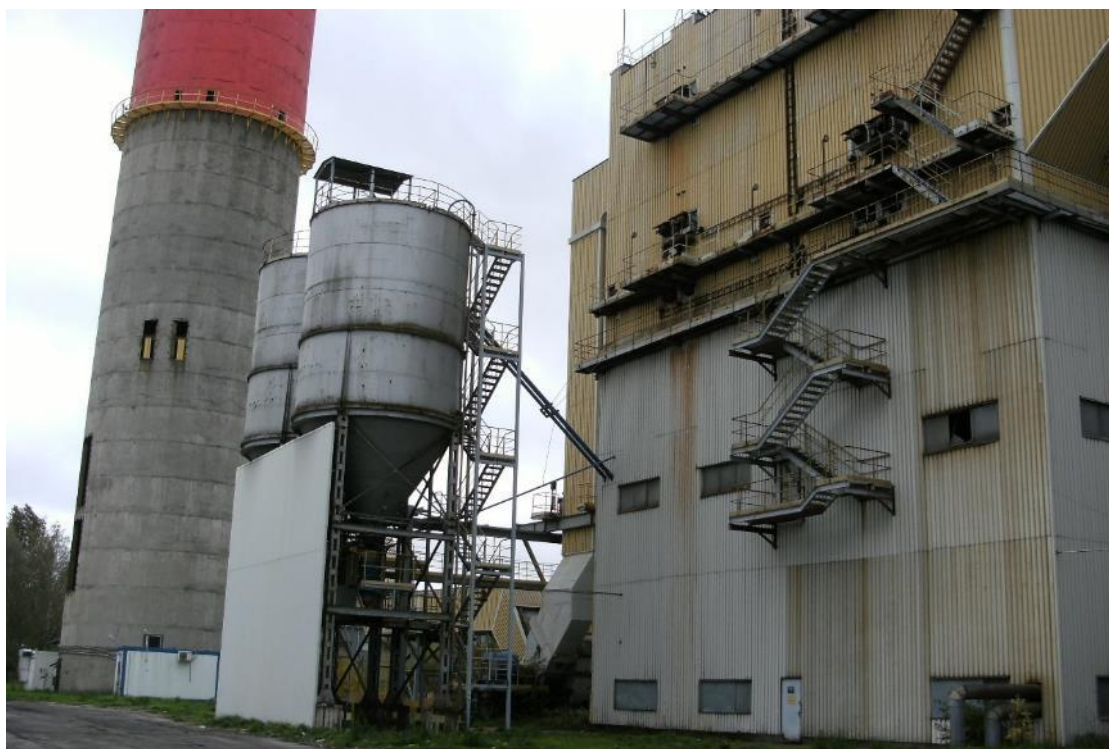
Fot. 134 Silosy - widok na stronę północną-wschodnią
