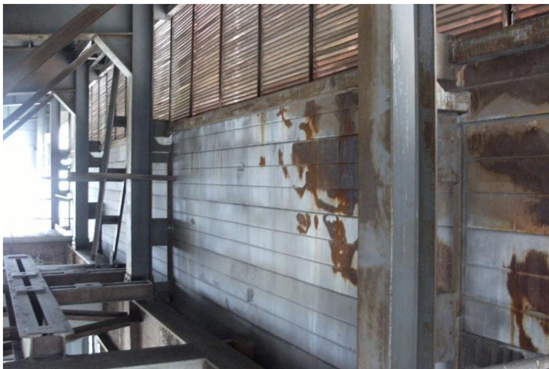
Fot. 45 Budynek BGK – widok wnętrza III piętra – konstrukcja ścian
