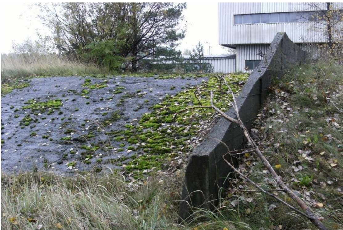
Fot. 113 Przenośnik węgla – widok na most nr 2
