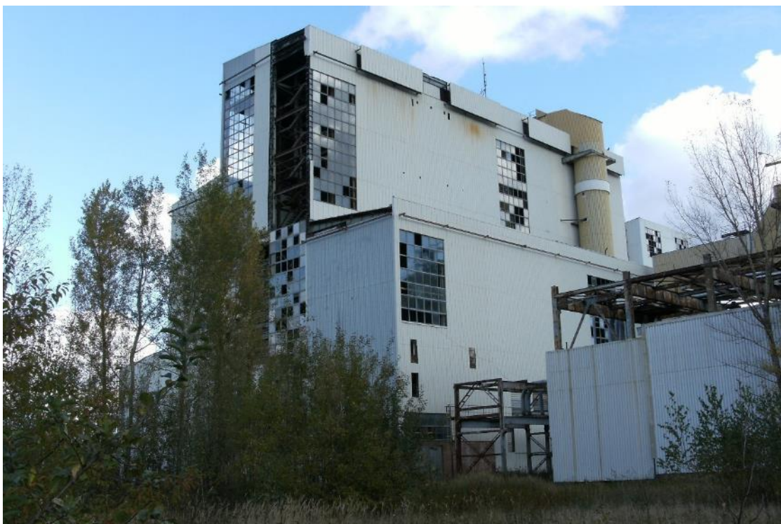
Fot. 37 Budynek BGK – widok na elewację południowo-zachodnią
