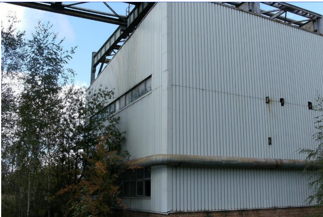
Fot. 17 Budynek PB – widok elewacji południowej
