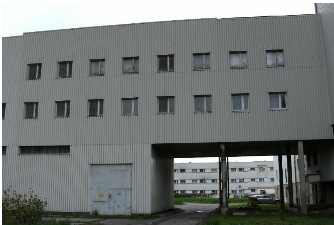
Fot. 72 Budynek BUT – widok na elewację południową
