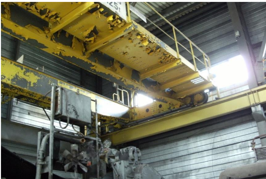
Fot. 121 Budynek przesypu nr 4 - widok wnętrza na suwnicę
