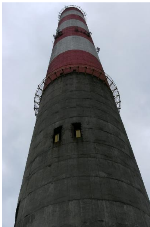
Fot. 88 Komin żelbetowy – widok górnej części komina
