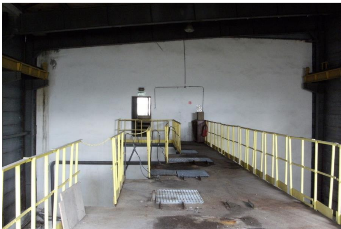
Fot. 33 Budynek BRiNO - widok wnętrza – piętro widok na ścianę południową do strony hali pomp
