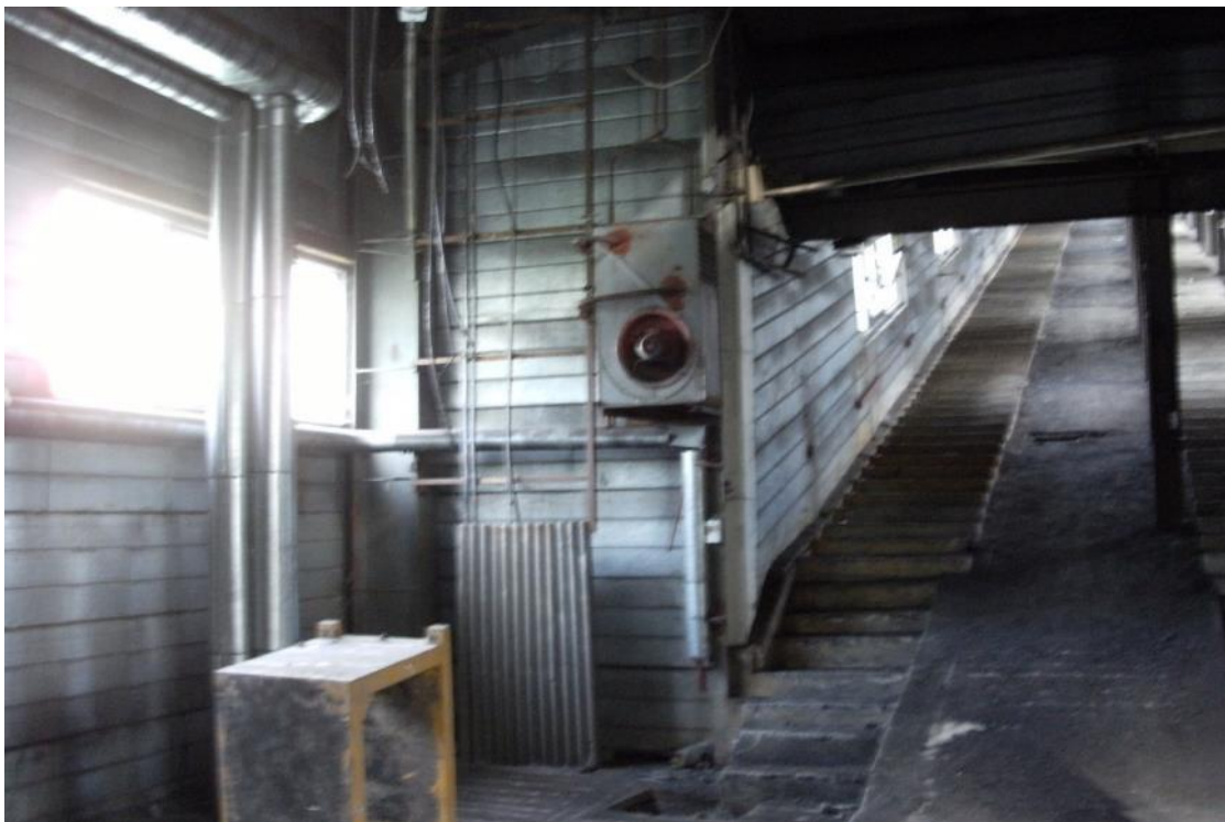
Fot. 117 Budynek przesypu nr 4 - widok wnętrza na most nr 4
