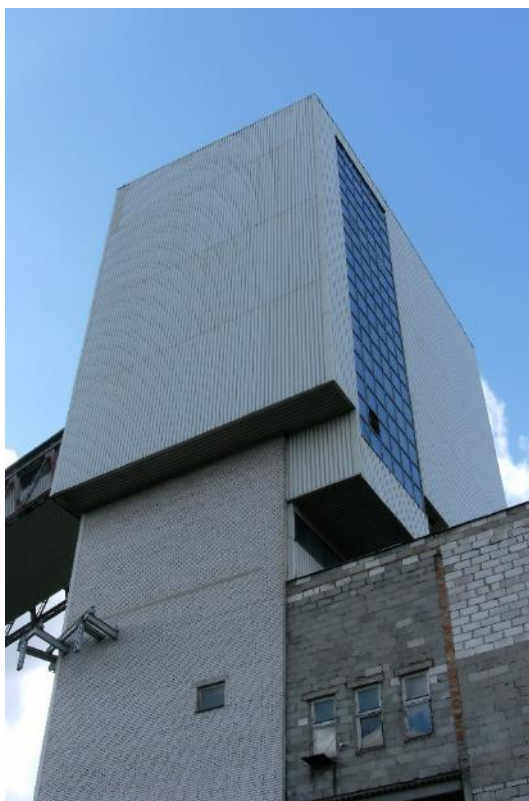
Fot. 97 Wieża nawęglania – widok na elewację północno-wschodnią
