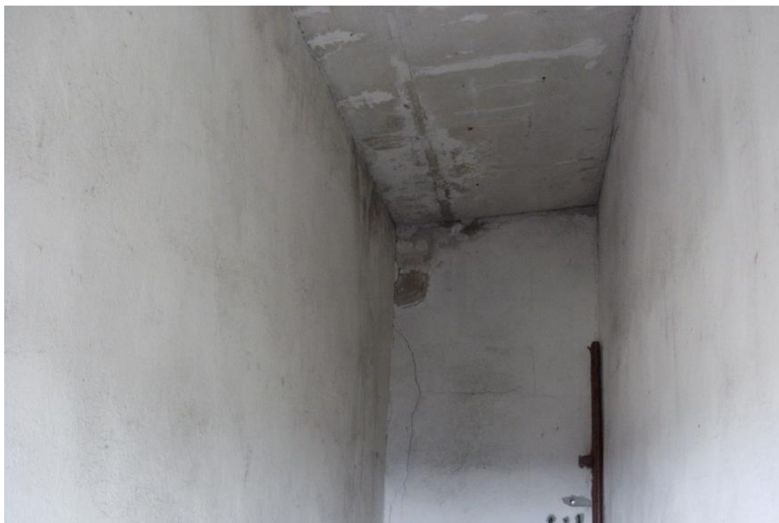
Fot. 42 Budynek BGK – widok wnętrza – wyjście na dach
